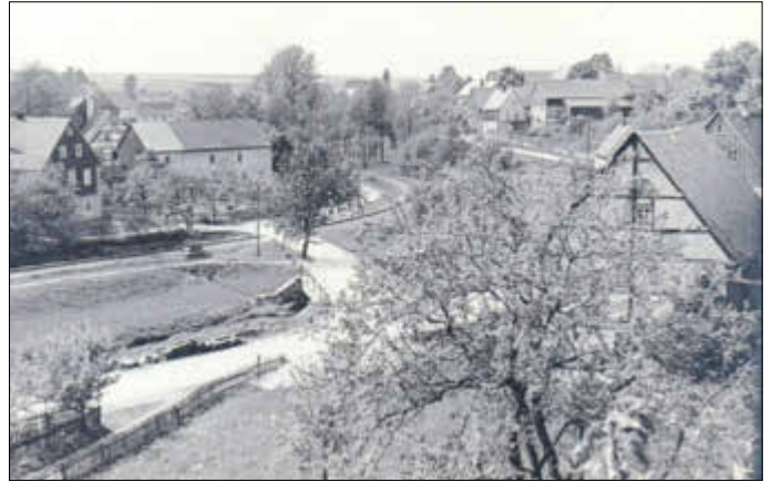
Blick vom Pfarrhaus Niederschöna auf die Bahnstrecke im Unterdorf (Wutke)
