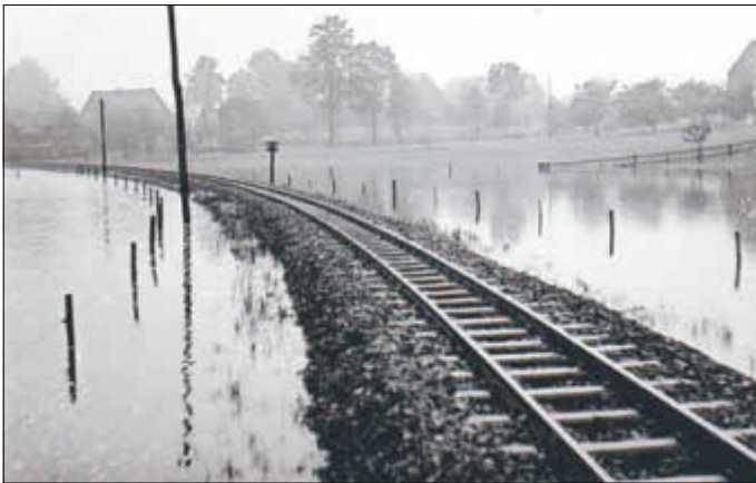
Glücklicherweise hält das Gleisbett der Bahn im Niederschönaer Unterdorf dem Hochwasser 1954 stand. (Ortsarchiv)
